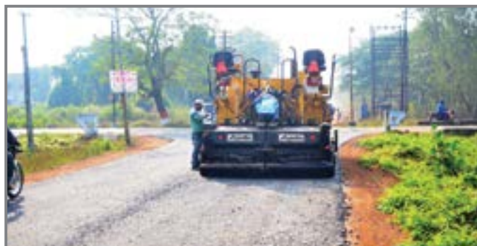
चित्र 5.3: बिना किसी संकेत, डिलिनियेटर्स या चेतावनी चिह्न वाले निर्माण स्थल
