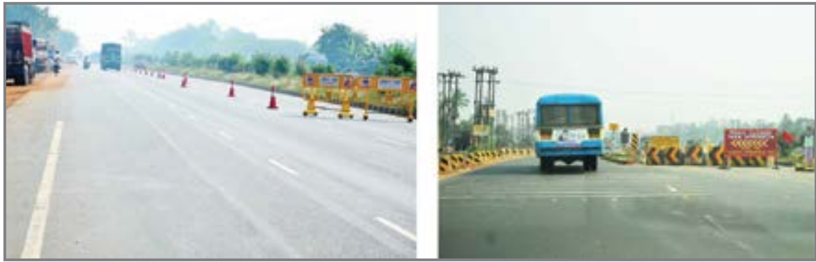
चित्र 5.2: डिलिनियेटर्स एवं मार्ग परिवर्तन चिह्न वाले विभिन्न निर्माण स्थल
